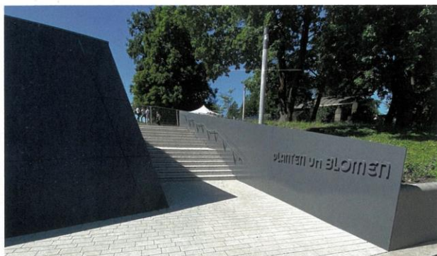
Neuer Hauptzugang zu Planten un Blumen in Hamburg © Buthmann Ingenieur-Stahlbau AG
