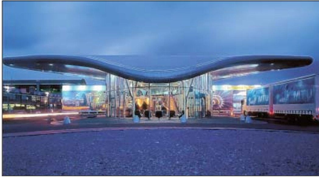
Das Stahlgerüst des Empfangsgebäudes der Lufthansa Technik AG, das am Hamburger Flughafen steht, wurde an der Glinde Humboldtstraße von Buthmann gebaut.
