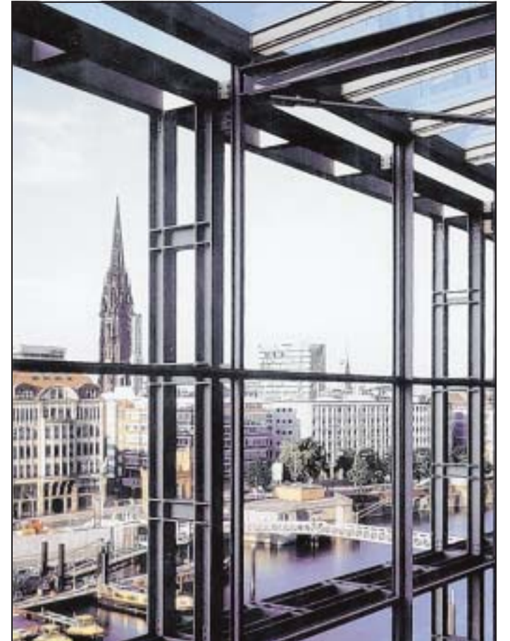
Auch die Konstruktion des Hanseatic Trade Centers am Baumwall stammt aus Glinde.
